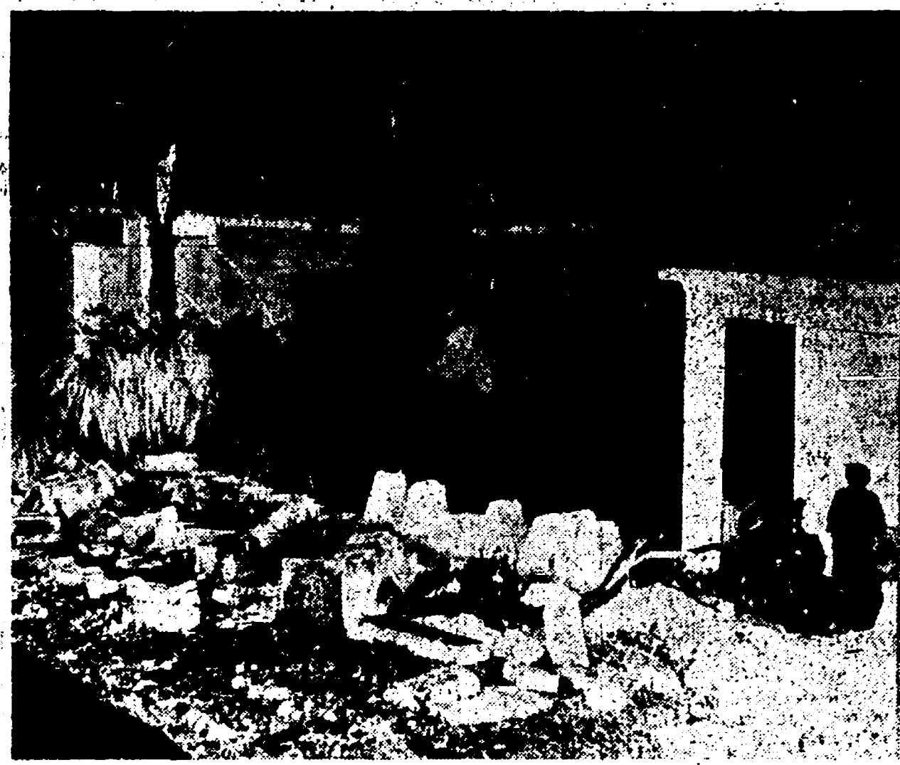
Una tromba d'aria, che dal Tirreno si è diretta verso l'interno, ha colpito in pieno Tarquinia. Quasi tutte le case della cittadina — come mostra la foto — hanno subito gravi danni. Fortunatamente quando il ciclone si è abbattuto sulla località, pioveva violentemente e pochissime persone sono state sorprese allo scoperto. I danni, secondo i primi accertamenti, sono di quasi mezzo miliardo. Anche Roma è rimasta a lungo paralizzata dal nubifragio.
