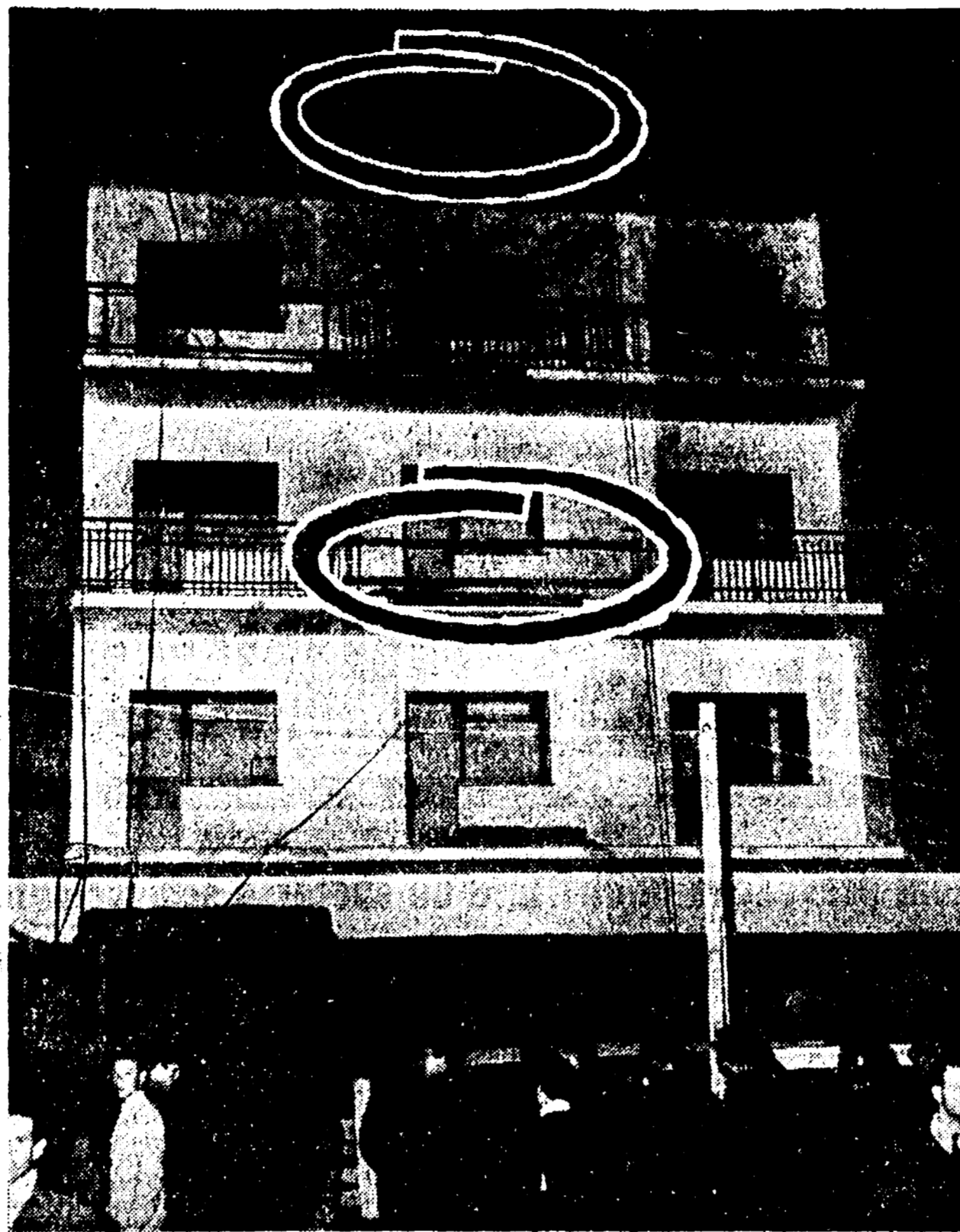
Si distinguono i travi legati col filo di ferro, al secondo e terzo piano, che il padrone per celare le sue responsabilità ha fatto mettere dopo la sciagura. A destra: la moglie di Vincenzo Graziani, disperata, trattenuta da alcune amiche dinanzi al cantiere ove è morto il marito
