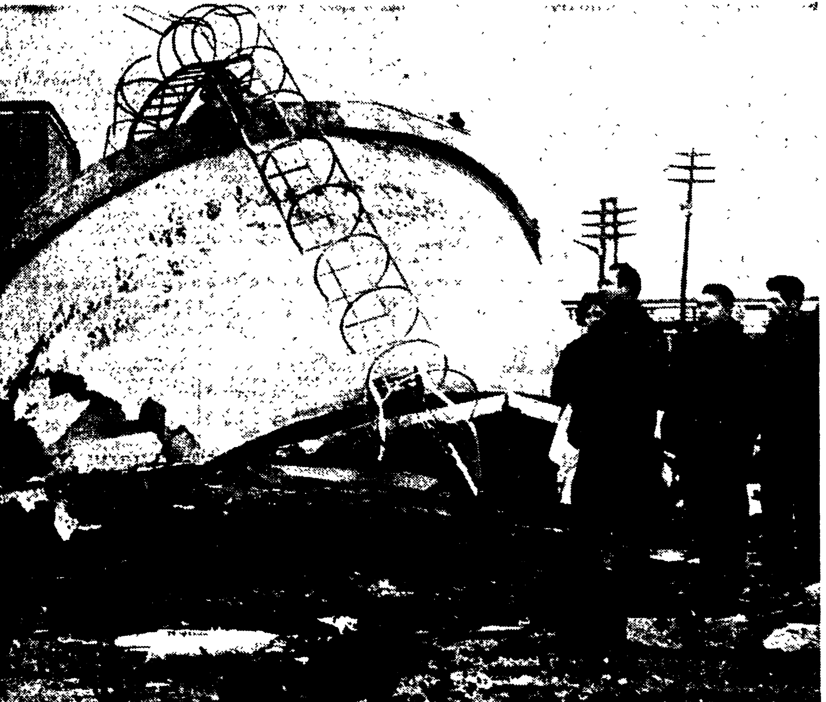
CATANIA — Un grosso serbatoio d'acqua abbattuto e spaccato dalla tromba d'aria
