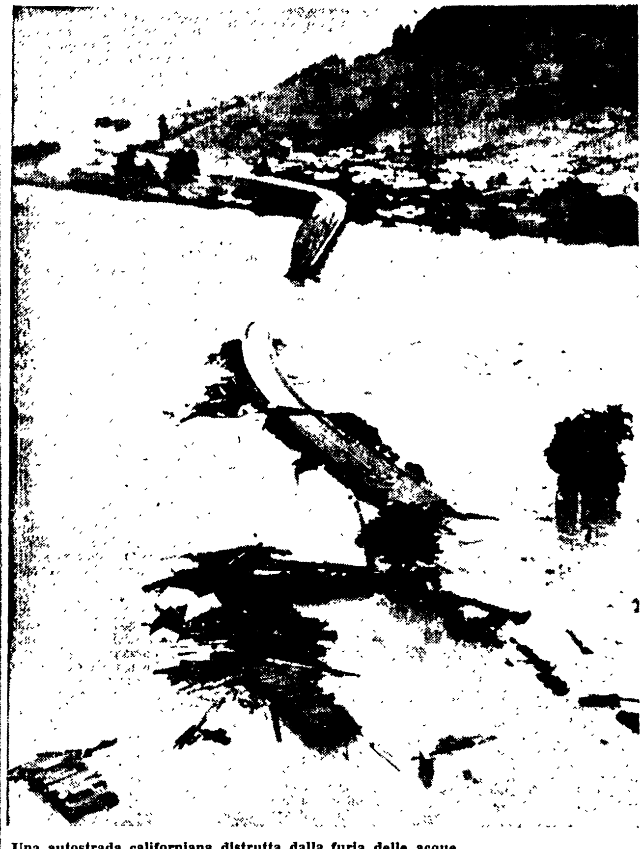
Una autostrada californiana distrutta dalla furia delle acque
