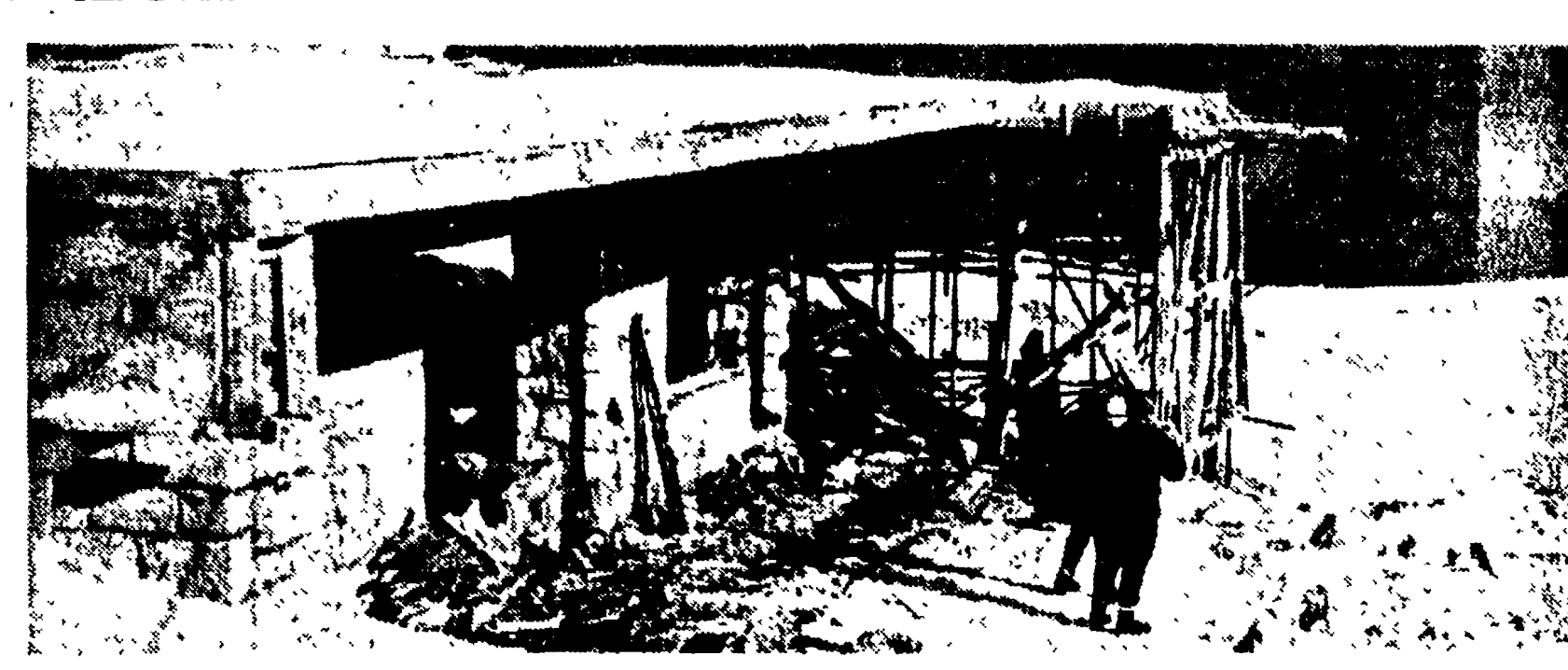
La stazione di arrivo della cabinovia di Monte Piselli (Ascoli Piceno) in via di ultimazione
