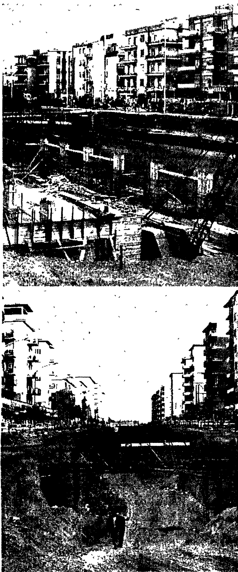
Due aspetti dei lavori della Metropolitana. In tredici mesi di attività, sono stati scavati meno di mille metri di trincea. E tra due anni, secondo il capitolato di appalto, tutto dovrebbe essere finito!
