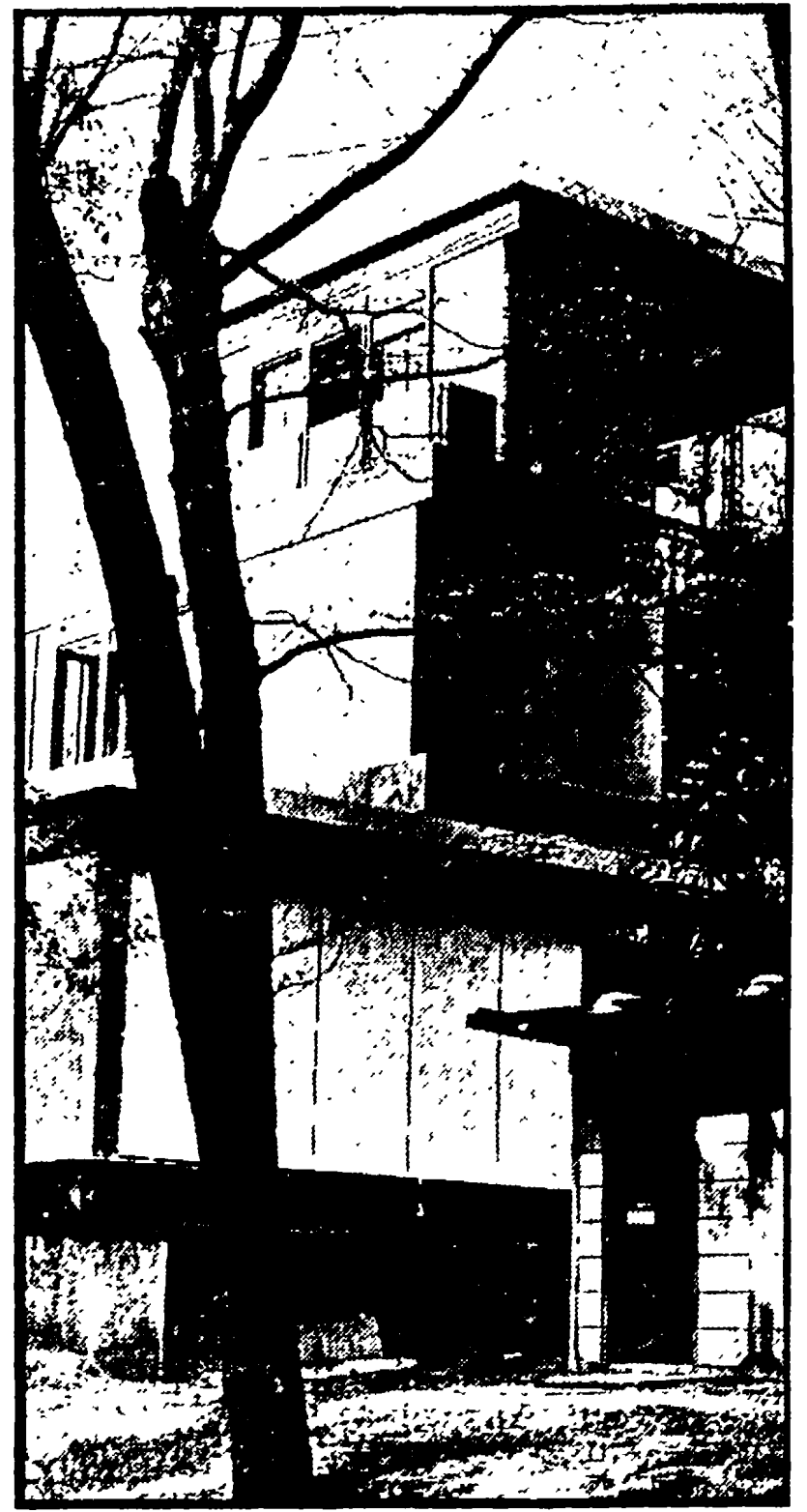
Esempi di realizzazione con elementi modulari in acciaio e pannelli in resina
