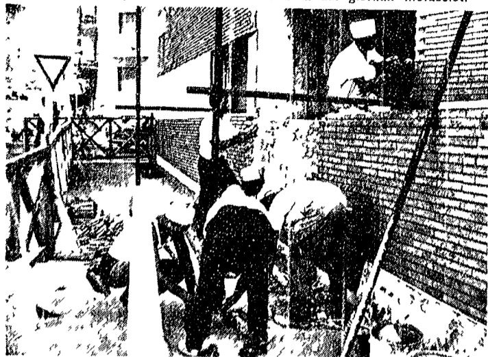
Alcuni operai procedono alla riparazione del muro danneggiato dall'esplosione della bomba
