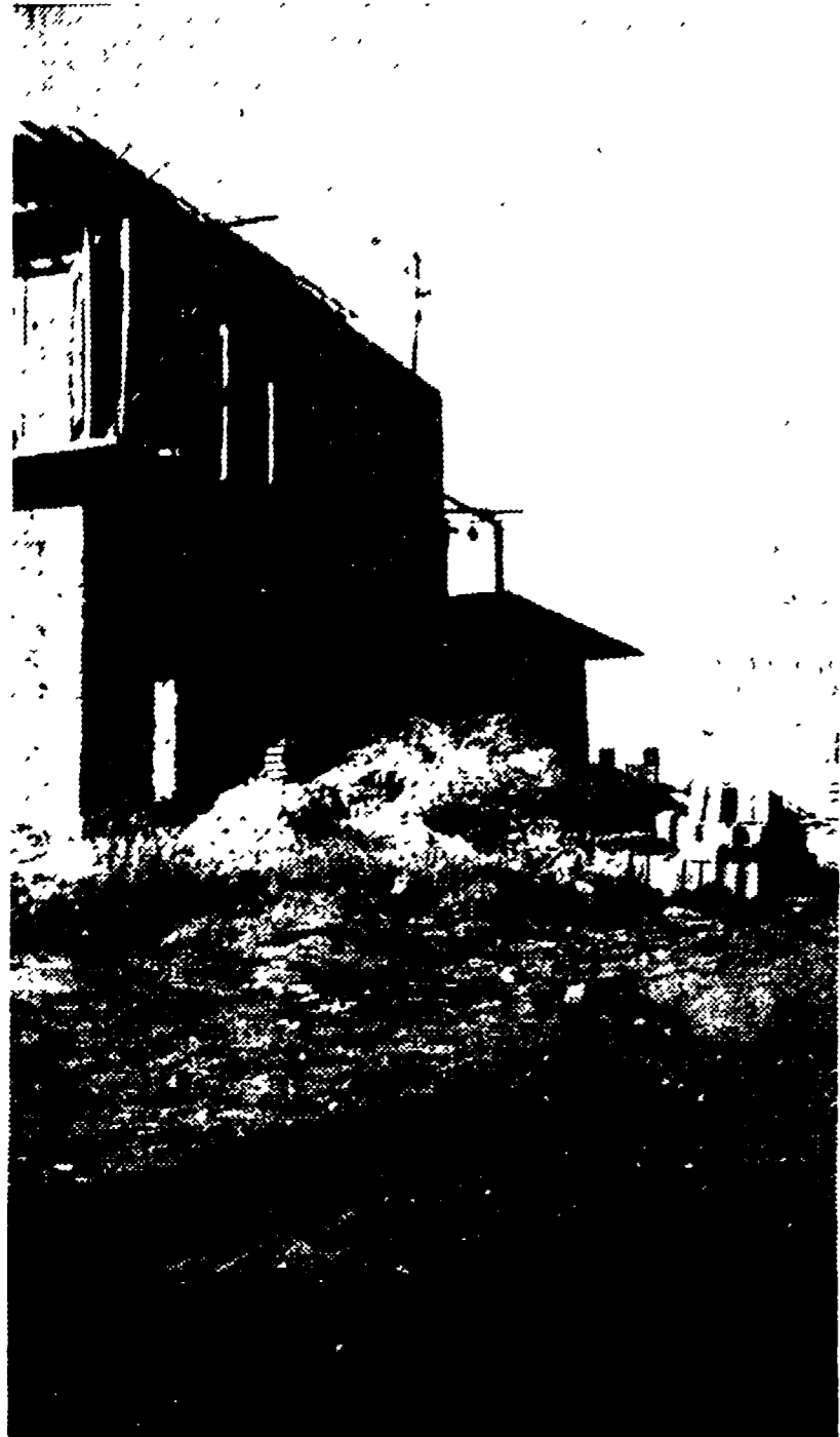
Casa in costruzione e una delle strade già tracciate e che portano al Raccordo Anulare su cui si affaccia la lottizzazione abusiva
