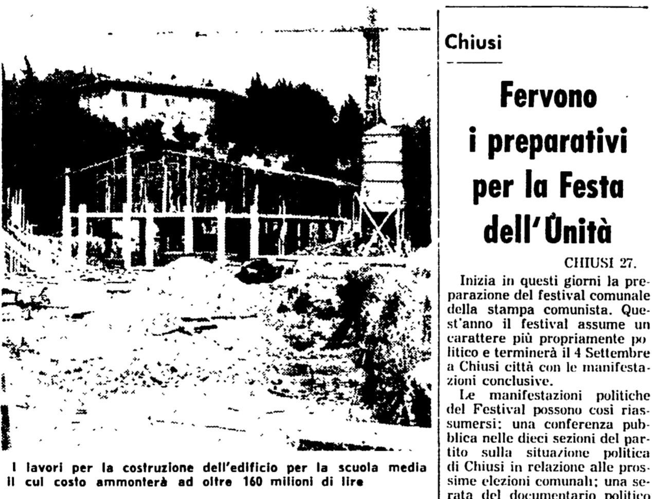
I lavori per la costruzione dell'edificio per la scuola media. Il cui costo ammonta ad oltre 160 milioni di lire
