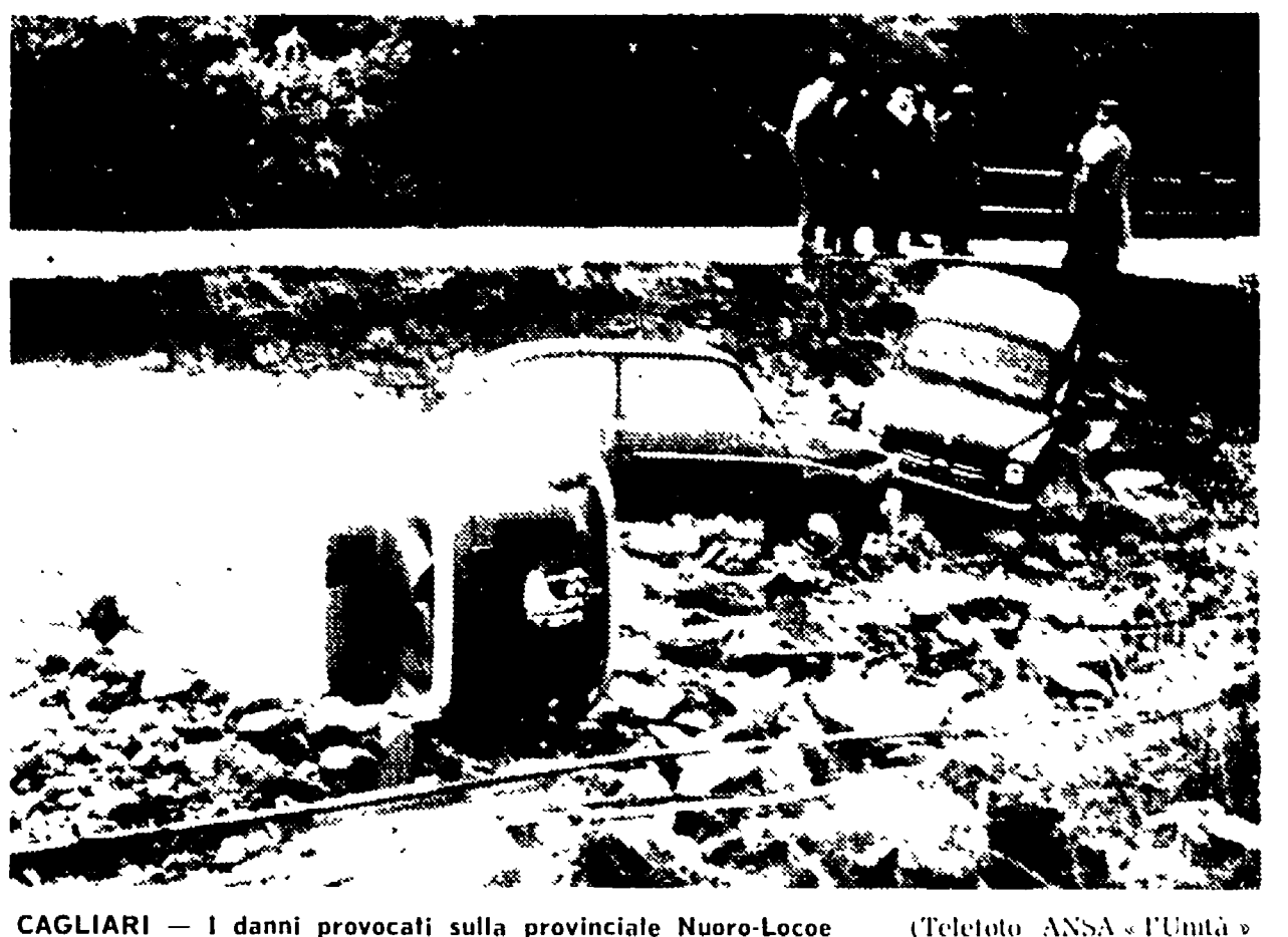
CAGLIARI - I danni provocati sulla provinciale Nuoro-Locove (Teletoto ANSA-L'Unità)
