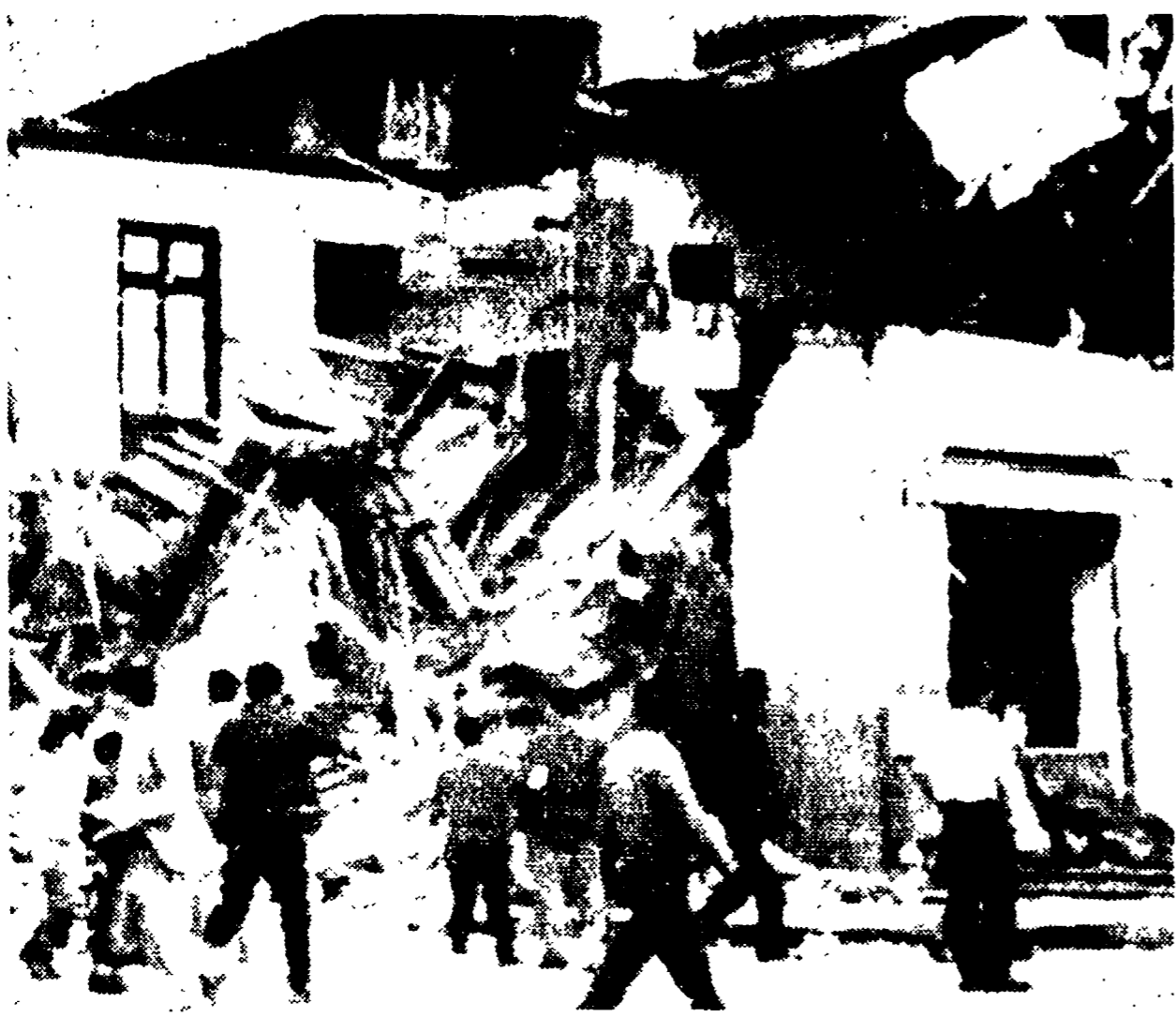
LIMA - Un edificio completamente crollato ed altri gravemente danneggiati dal terremoto.
