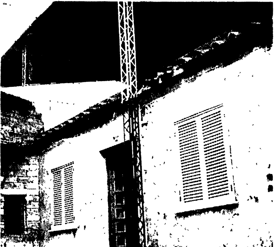
L'ingresso della scuola elementare di Tor Angela. Per impedire che, come è successo molte volte, nelle aule piovesse, il proprietario ha addirittura costruito un altro tetto.
