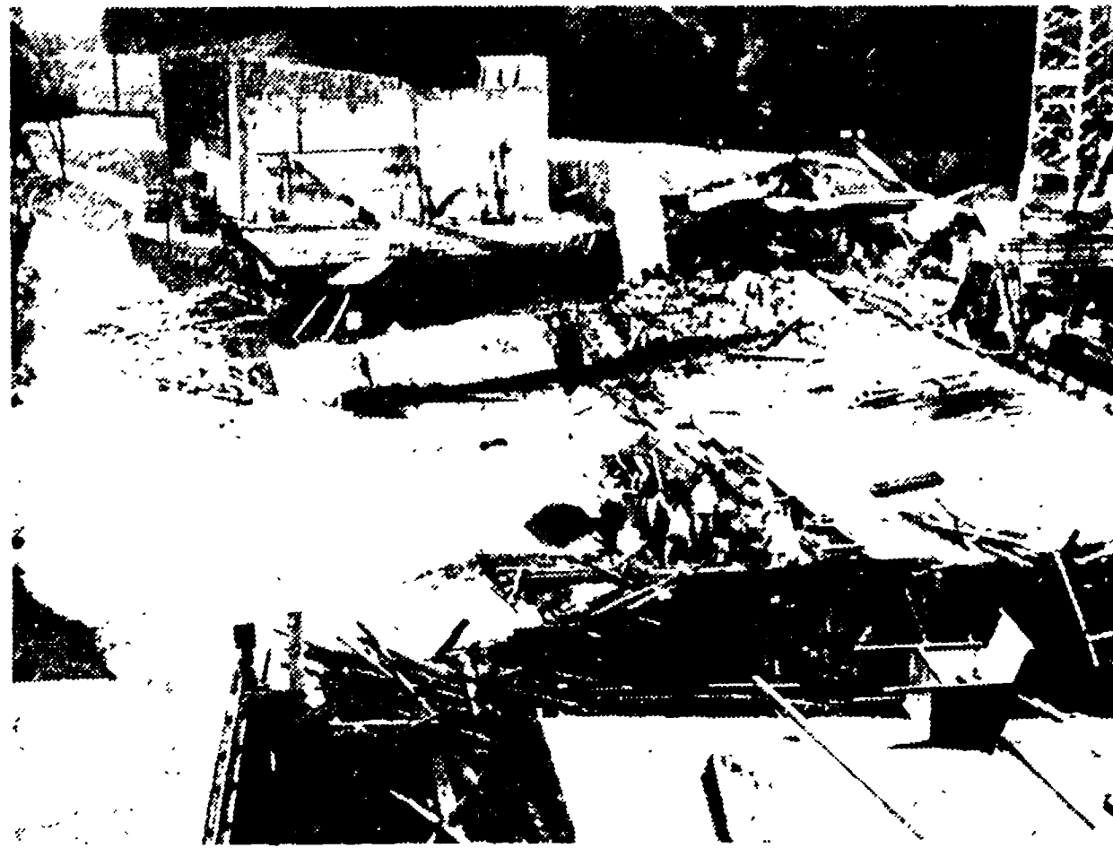
ZURIGO — Sedici operai, quattro dei quali italiani, hanno riportato ferite di varia entità nel crollo di un ponte costretto sull'autostrada che dovrà collegare San Gallo a Winterthur. Nella foto: una veduta panoramica della massicciata in cemento crollata quasi interamente nel letto del sottostante fiume Toss
