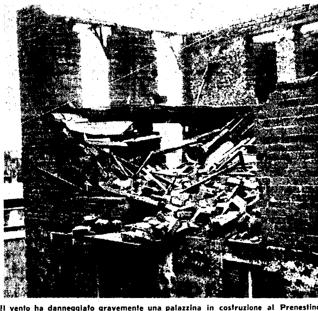
Il vento ha danneggiato gravemente una palazzina in costruzione al Prenestino.
