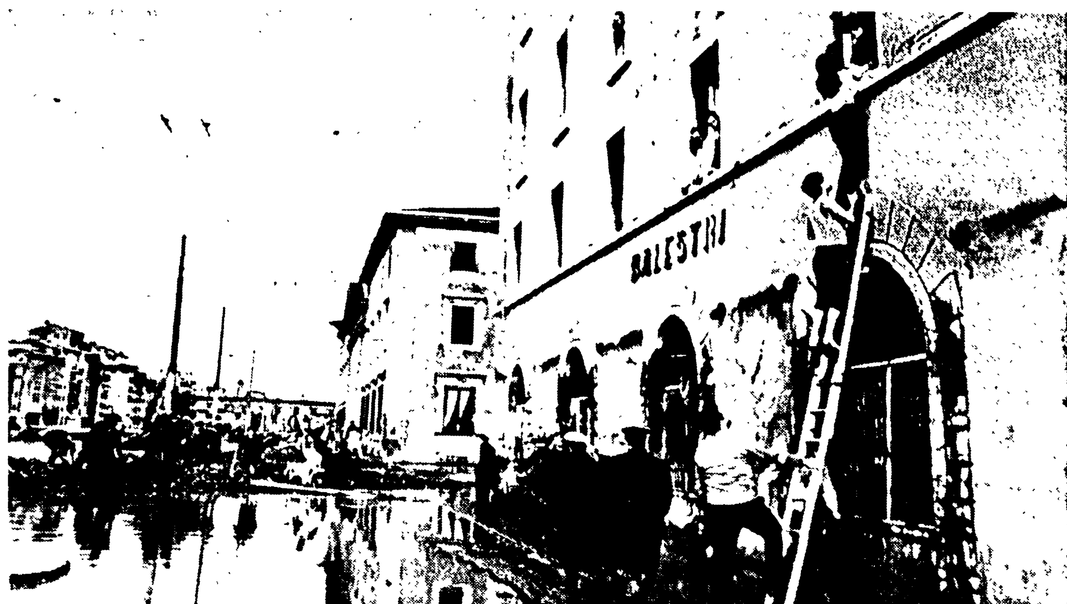
FIRENZE — Una drammatica immagine del Lungarno, fra il Ponte Vecchio e il Ponte alle Grazie. La spalleda del fiume è stata completamente divelta dalla furia della piena. L'acqua, in breve tempo, ha raggiunto (come si vede chiaramente nella foto) il primo piano dell'Albergo Balestri. (Telefoto ANSA)
