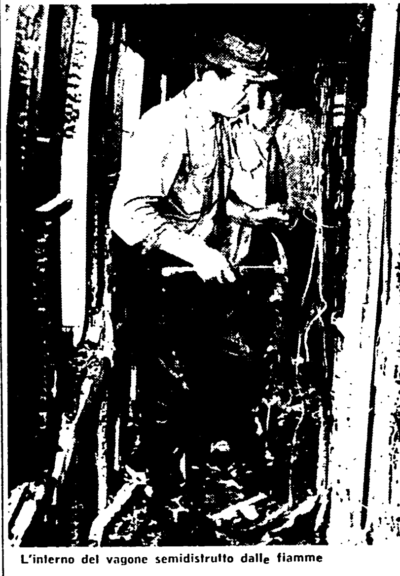
L'interno del vagone semidistrutto dalle fiamme
