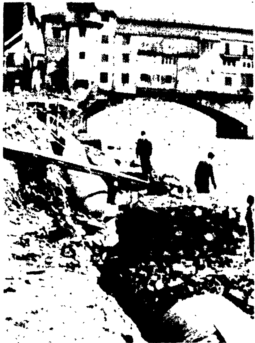
FIRENZE — Alcuni operai sul Lungarno Acciaioi crollato in seguito all'alluvione. (Tel. ANSA)
