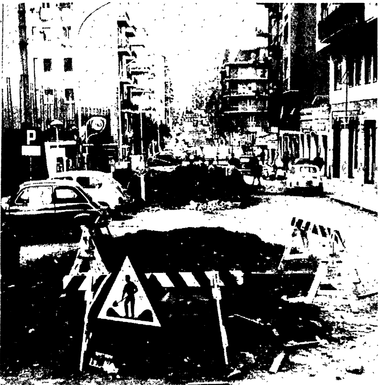
Ecco come appare via Jenner sconvolta da lavori stradali che sembrano non finire mai.
