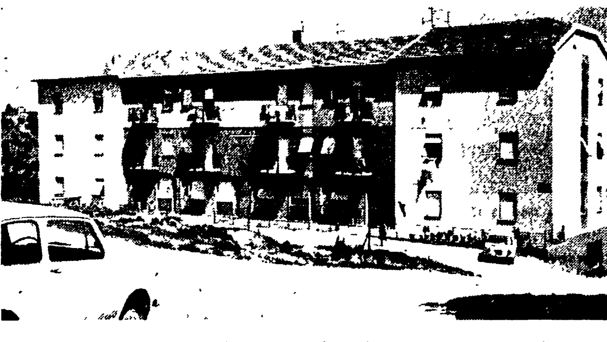
Ecco un edificio sito in rione Pinocchio sorto su un'area che il Piano regolatore vincolava a spazio pubblico. In particolare, nell'area era prevista la costruzione di un mercato rionale.
