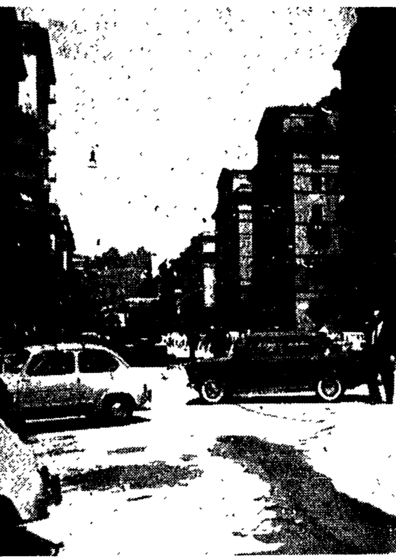
Via della Giuliana bloccata mentre sono in corso i lavori.
