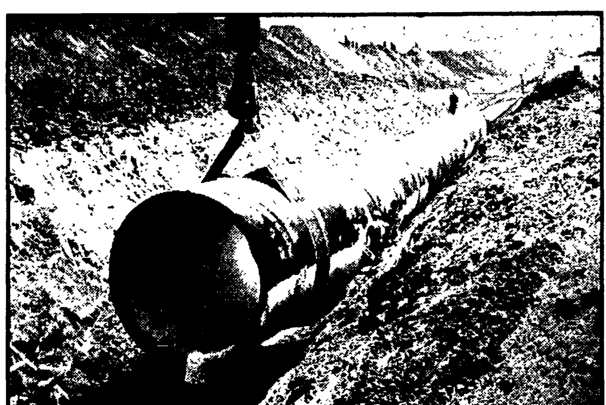
I lavori di installazione dell'acquedotto recentemente completato che convoglia le acque dal bacino del Lago di Tiberiade verso le regioni aride del centro e del sud di Israele. Il controllo delle sorgenti idriche è uno dei motivi di frizione tra Israele e la Siria.
