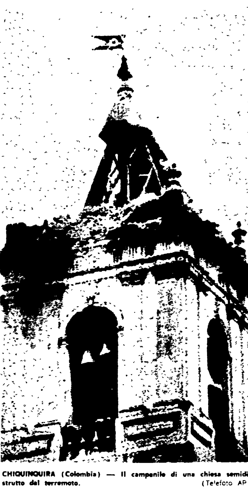
CHICUQUIRA (Colombia) — Il campanile di una chiesa semi-distrutta del terremoto. (Telefoto AP)
