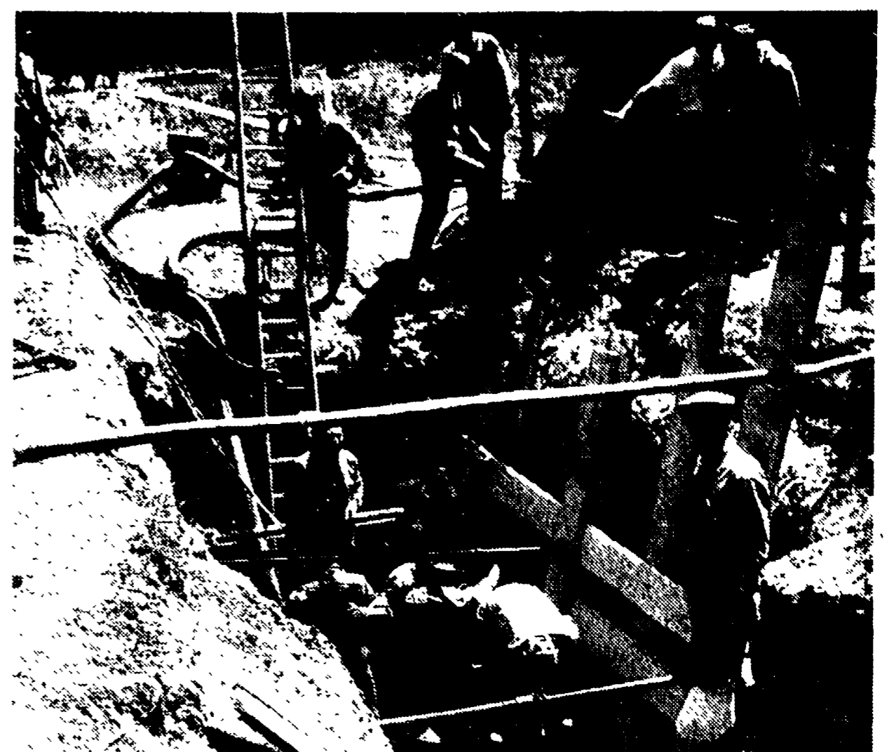
Il pozzo dove è avvenuto il tragico crollo
