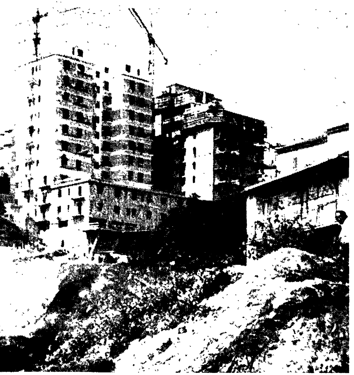
CHIETI — Il fabbricato Micheli, in via N. da Guardiagrele, visto dal lato della frana. E' stato costruito in maniera difforme dal progetto approvato
