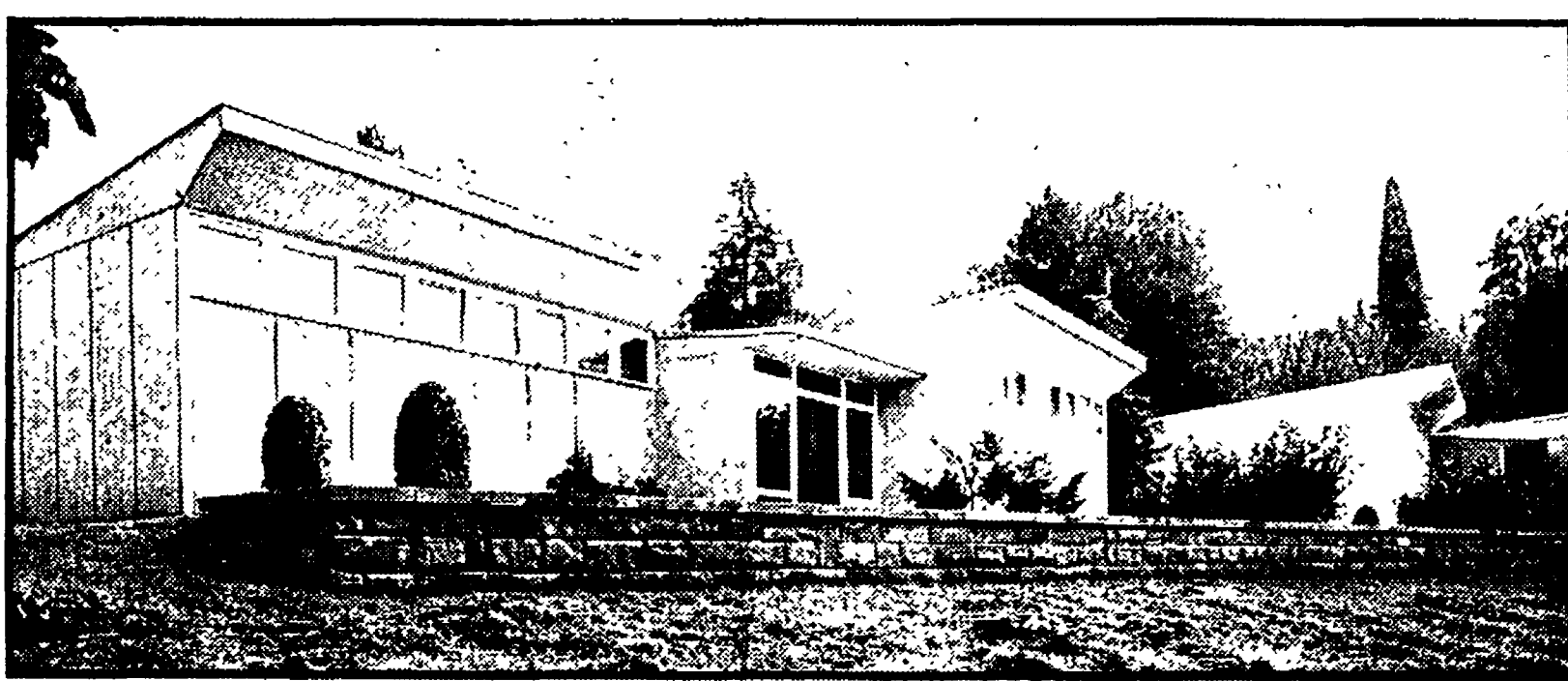
L'aula speciale di una « scuola all'aperto » di Bologna (foto in alto). Una « scuola all'aperto » costruita dall'Amministrazione comunale bolognese (sotto).
