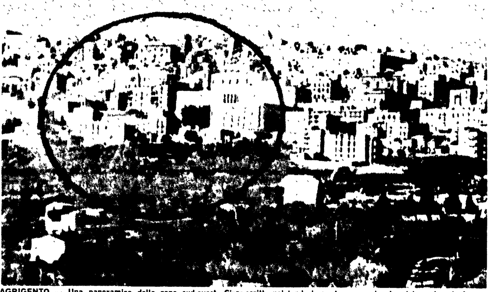
AGRIGENTO - Una panoramica della zona sud-ovest. Circo scritta nel fondo la vasta zona epicentro del movimento franoso
