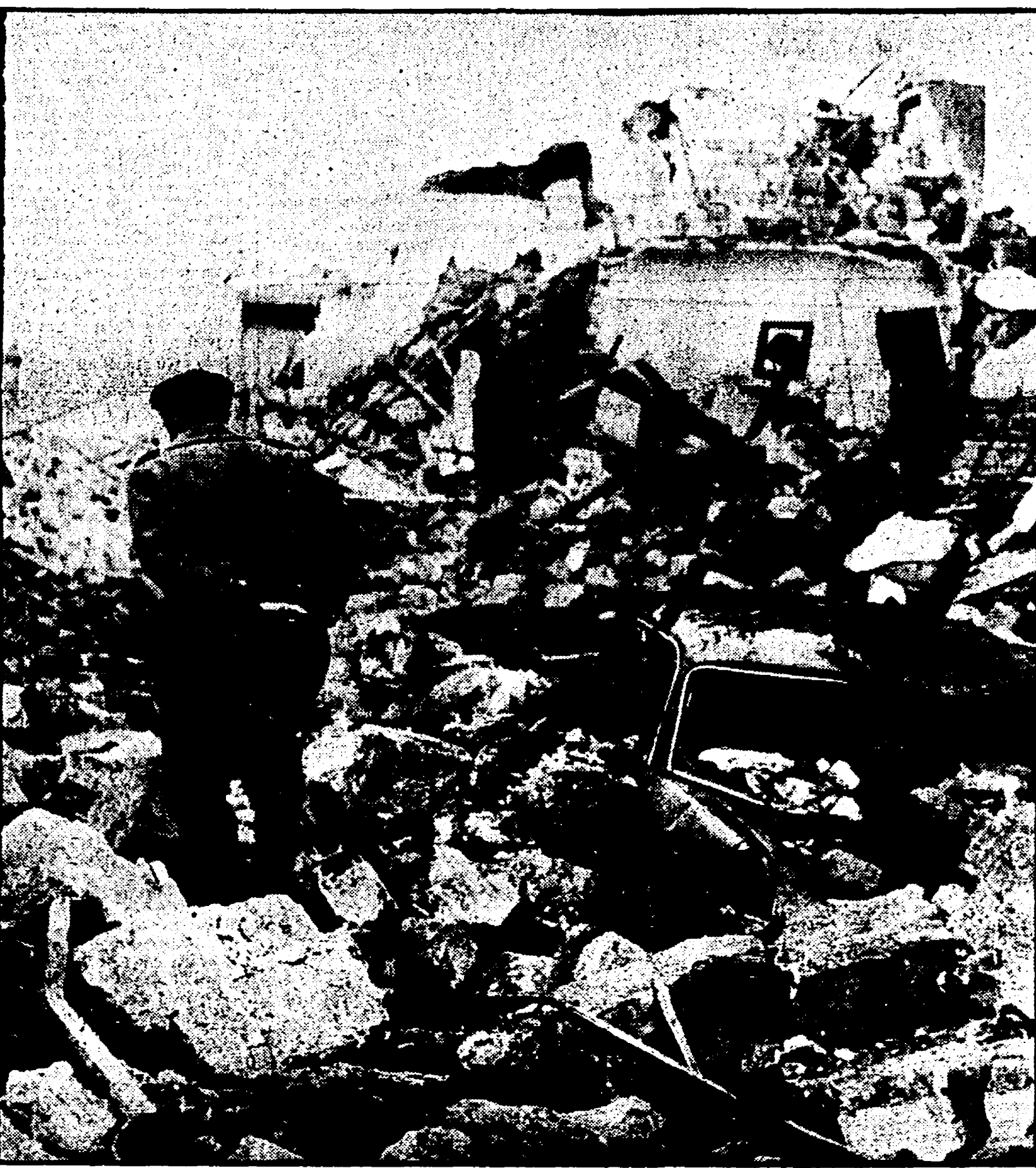
MONTEVAGO - Il rapporto ministeriale dice laconico: « Montevago, provincia di Agrigento. Totalmente distrutto. Tutte le case, comprese le chiese, il municipio, le scuole, sono crollate. Tutti gli impianti igienici, le strade, l'elettricità dovranno essere di nuovo costruiti. Almeno 200 i morti, 150 mila i metri cubi di macerie da asportare. Solo da poche ore i primi soccorritori sono arrivati a misurare tanta desolazione: sono due continue di macerie, più alle della statura umana. (Tel. Pais-Sartarelli)
