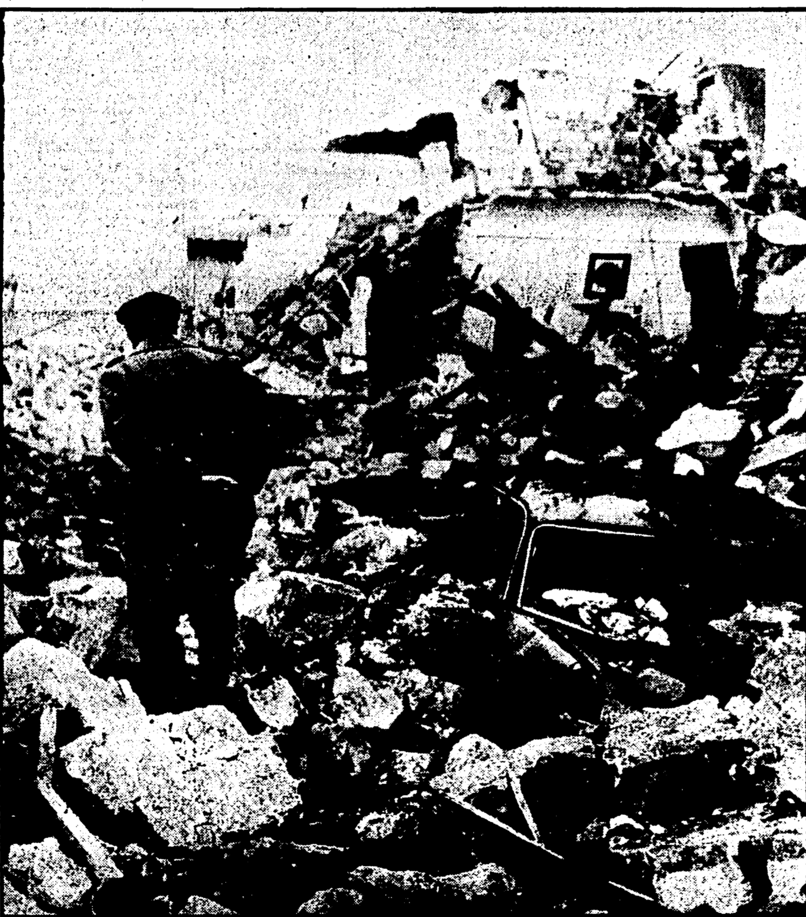
MONTEVAGO — Il rapporto ministeriale dice laconico: « Montevago, provincia di Agrigento. Totalmente distrutto. Tutte le case, comprese le chiese, il municipio, le scuole, sono crollate. Tutti gli impianti igienici, le strade; l'elettricità dovranno essere di nuovo costruiti. Almeno 200 i morti. 150 mila i metri cubi di macerie da asportare. « Solo da poche ore i primi sono arrivati a misurare tanta desolazione: sono due continue di macerie, più alte della statura umana. (Tel. Pais-Sartarelli)
