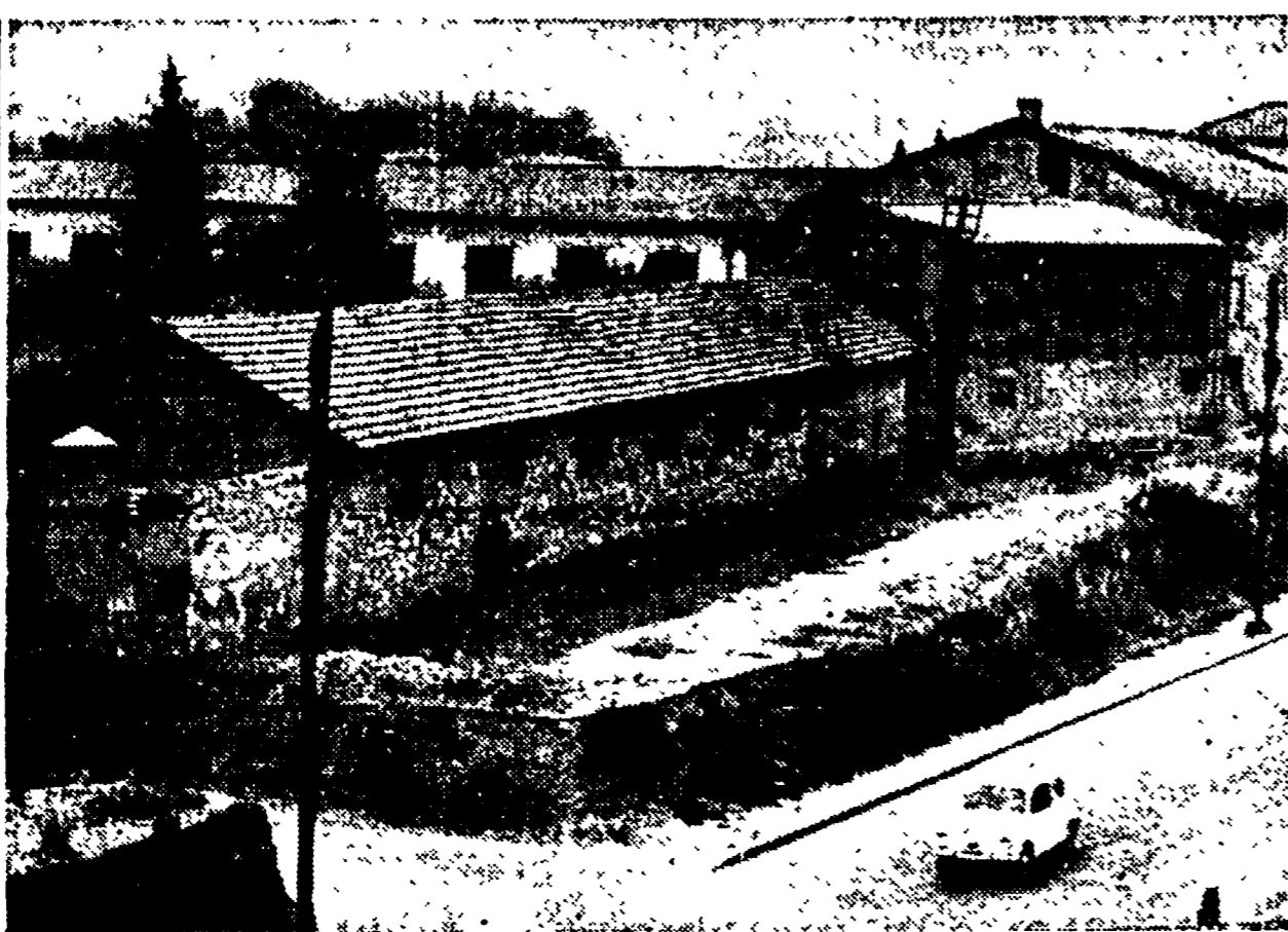
Un aspetto dell'ospedale-caserna di Terni
