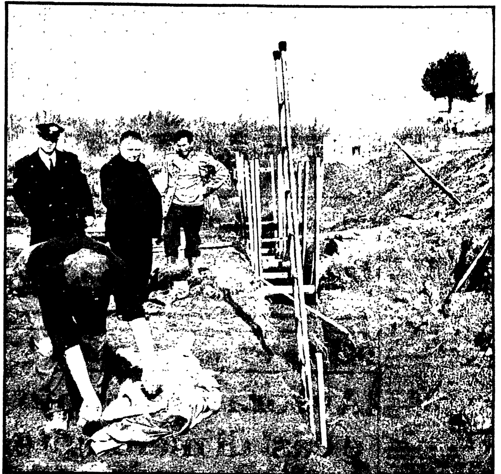
Il luogo della sciagura. Il corpo di un operaio ucciso è stato deposto ai margini dello scavo.
