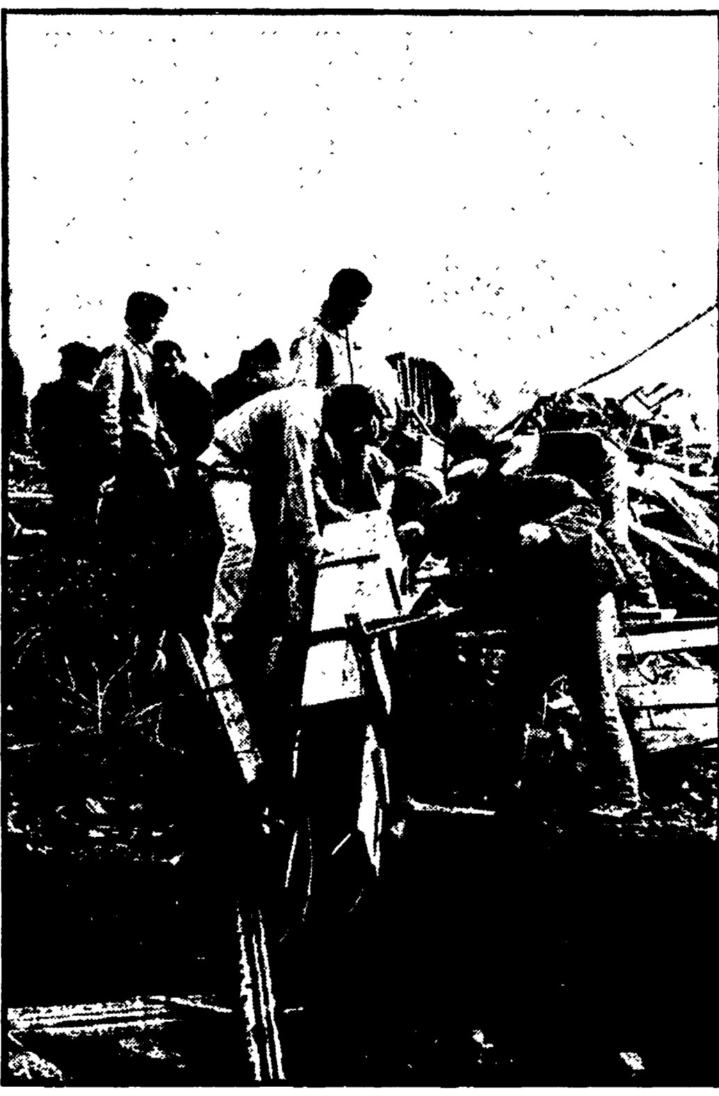
Gli edili mentre scavano fra le macerie della casa crollata
