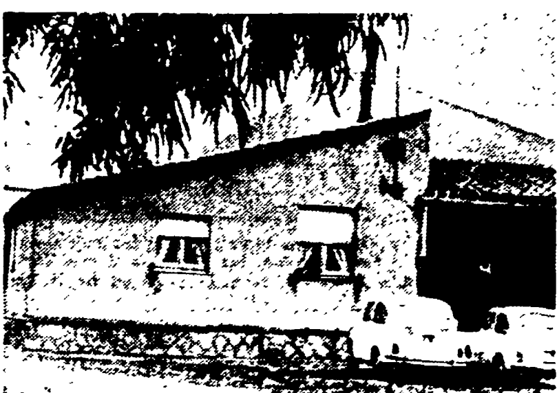
PIMENTEL (Cagliari) — La scuola elementare, chiusa per ordine dell'ufficiale sanitario
