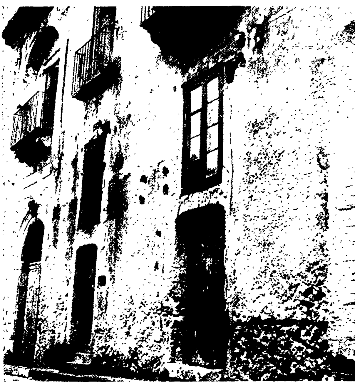
La facciata del vecchio palazzo comunale di Grotteria, pericolante dal 1953
