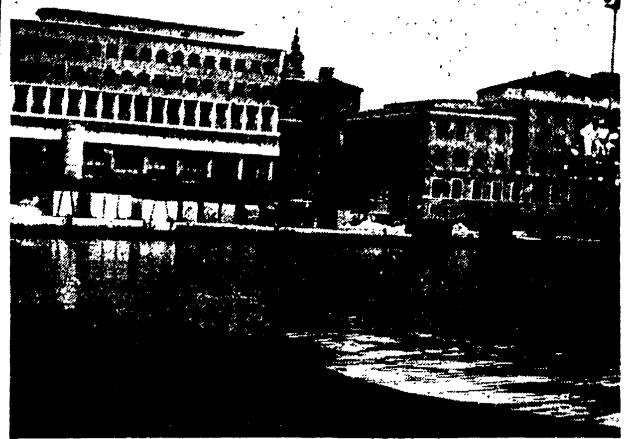
Lo specchio d'acqua antistante il varco della Repubblica: qui sono in via di ultimazione i lavori per la ristrutturazione della banchina e l'escavazione dei fondali
