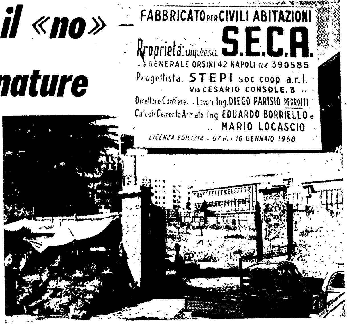
L'ingresso del cantiere all'angolo fra corso Europa e via Tasso, dove la società SECA costruirà un palazzo di volume e di altezza non consentiti, e le cui fognature, nonostante il parere contrario dell'apposito ufficio, si immetteranno sul dissestato collettore di via Tasso. Il cartello (foto piccola in alto) indica come progettista una società « Stepi » ma sotto il progetto in Comune c'è la sola firma dell'ingegnere Guizzi
