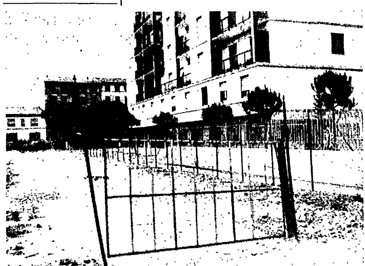
Via Baracchini è stata nuovamente chiusa al transito: al posto della rete innalzata nei giorni scorsi, ora è stata messa una cancellata che impedisce l'accesso su via Baracca. Ad onta del piano regolatore la società Esso continua ad impedire l'accesso sulla via Baracca. E il comune che fa?
