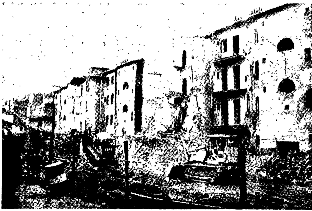
Squadre di operai stanno lavorando (nella foto) alla demolizione del «Casone» di via G. Orsini che a seguito dell'alluvione del 4 novembre 1966 rimase gravemente danneggiato
