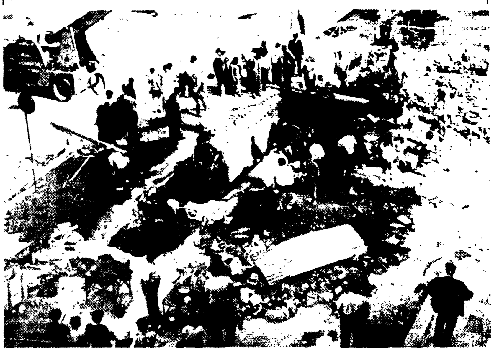
Un'ampia voragine anche al corso Novara: ancora una volta la strada è stata squarciata dalla rottura delle condutture dell'acquedotto che ha provocato la fuoriuscita di una colonna di acqua alto 12 metri. La sede stradale, ieri, è stata spaccata in diversi punti. Il cedimento di maggiori proporzioni si è avuto all'angolo tra il corso Novara, via Venezia e via Ferrara. Sono rimasti danneggiati notevolmente anche il corso Meridionale, via Genova e via Palermo. Ovviamente il traffico è interrotto e non sa ancora quando potrà essere riavviato. Per fortuna non si lamentano feriti; nel momento in cui si è avuta l'esplosione della tubatura sulla strada non c'era nessuno. Erano le 7,50 del giorno di festa e pochissime auto si trovavano a passare nella zona. I danni comunque, sono inent-
