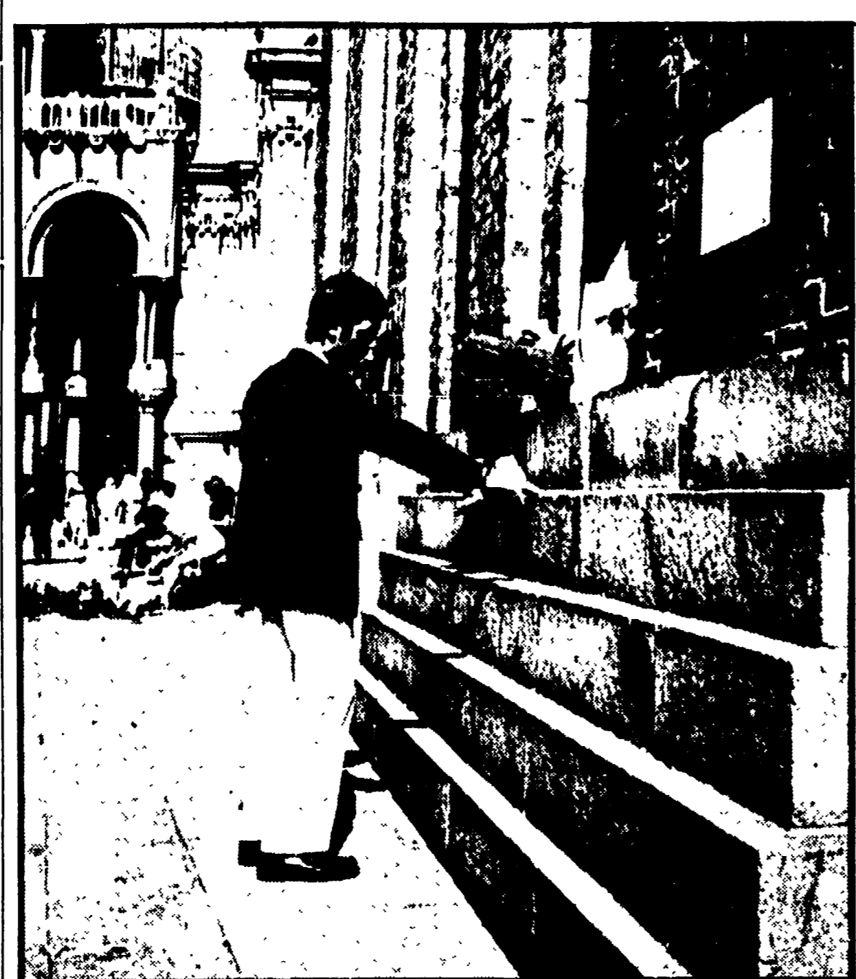
LESIONI A SAN MARCO. Numerose lesioni sono state trovate al basamento del campanile della basilica di San Marco, a Venezia. Nella foto: un veneziano indica le lesioni sui cinque gradini del basamento del campanile
