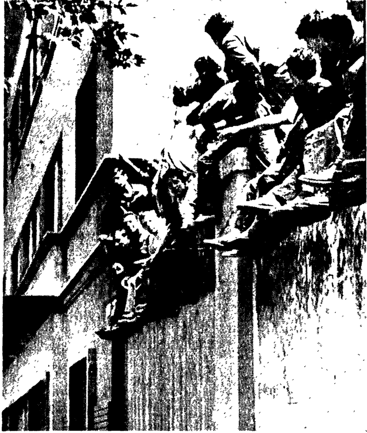
S'inasprisce la lotta dei cantieri navali di Palermo sostenuta dalla solidarietà popolare. La foto mostra un gruppo di operai del cantiere che riceve viveri dalla strada il giorno in cui Piaggio, per ritorsione, fece chiudere la mensa aziendale
