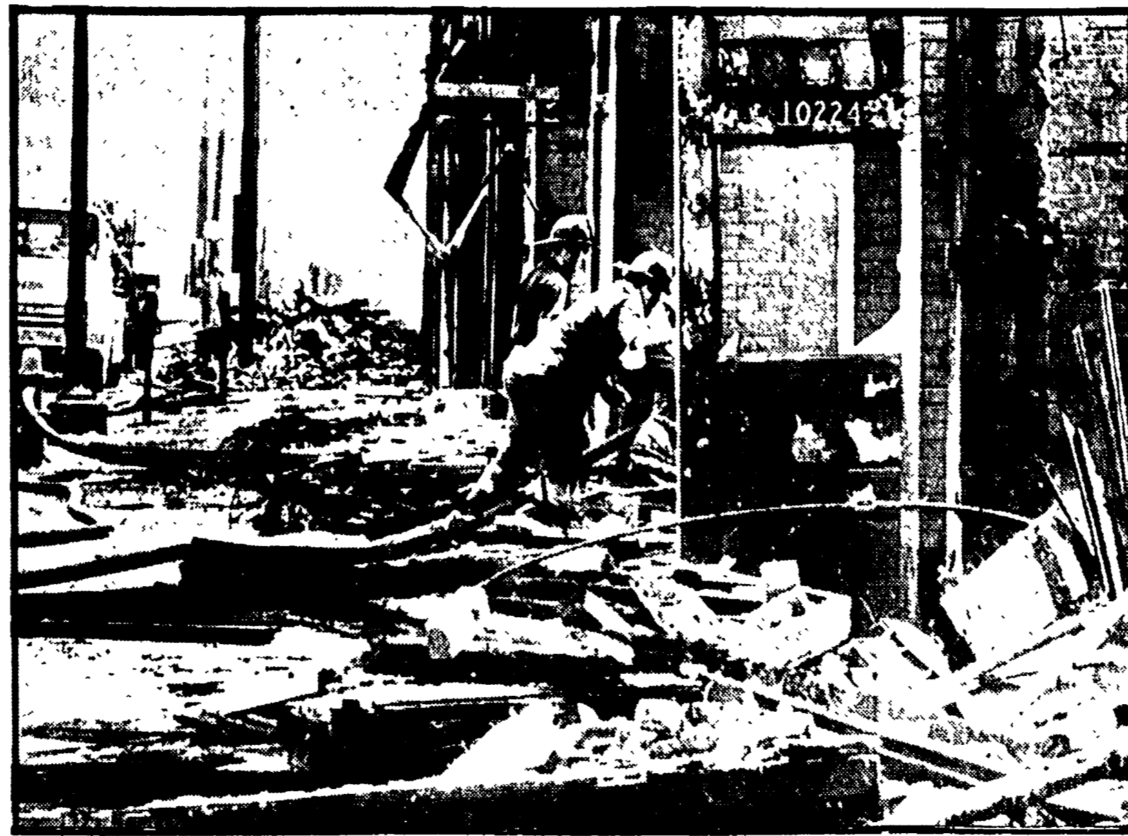
CLEVELAND — Vigili del fuoco ispezionano le macerie di alcuni edifici distrutti dagli incendi (Telefoto ANSA-L'Unità)
