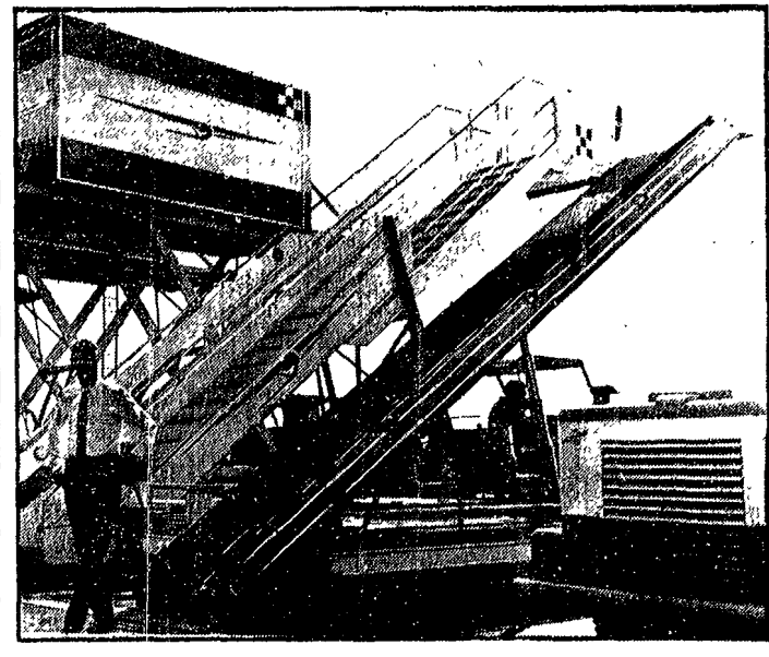
SCALE PER SUPERSONICI Sono stati presentati ieri a Fiumicino dei giganteschi sementieri che serviranno per l'assistenza a terra agli aerei supersonici. Le enormi scale sono in acciaio e cemento, raggiungono notevoli altezze paragonabili al secondo e terzo piano di un normale edificio.
