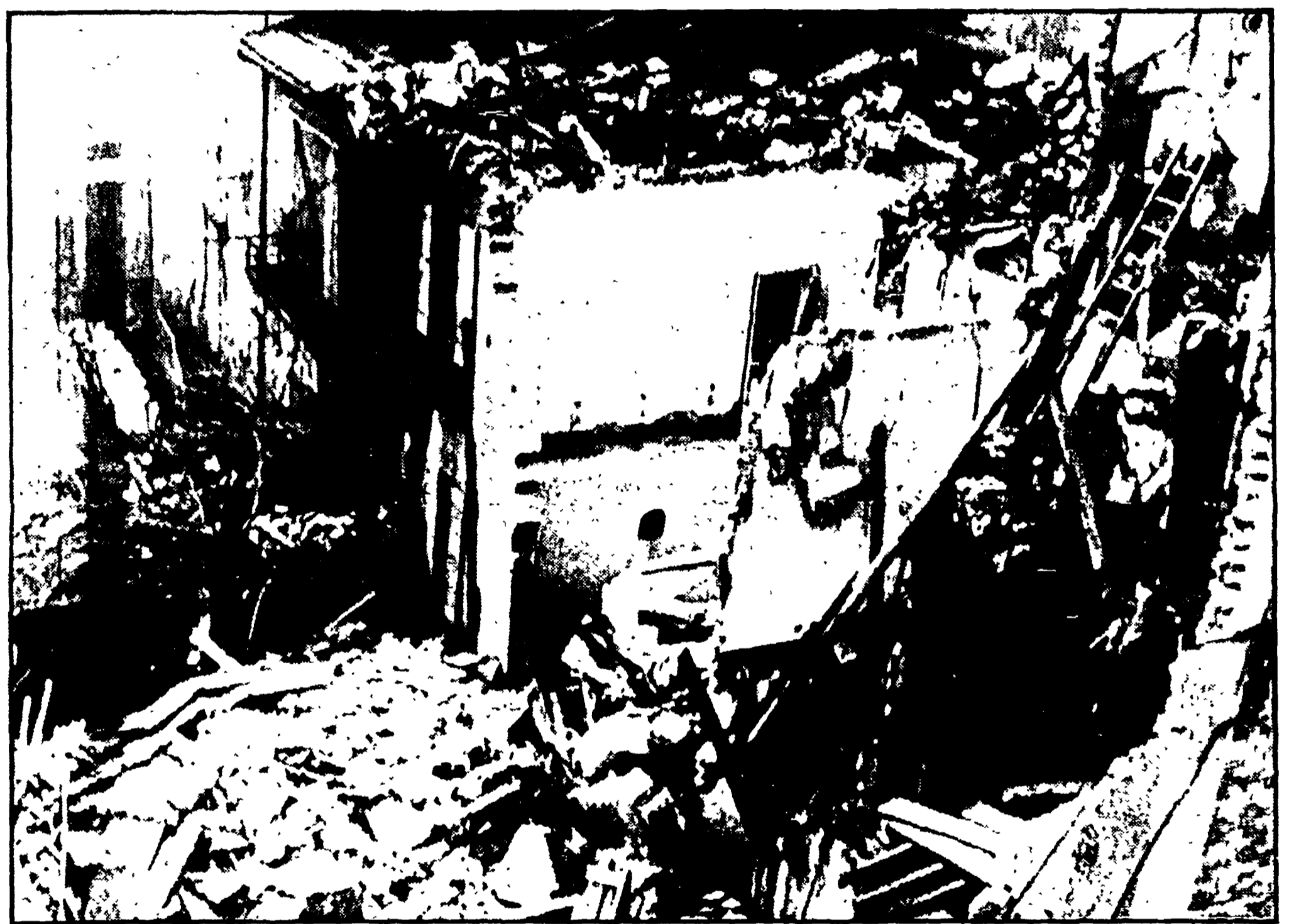
BOLOGNA — Una visione del palazzo esploso a causa di una fuga di gas. Dieci cadaveri sono stati recuperati, fra le macerie, dalle squadre di soccorso; i feriti sono stati dodici. I soccorritori hanno dovuto lavorare in condizioni di grande difficoltà, per evitare nuovi crolli dei muri lesionati. A PAGINA 5
