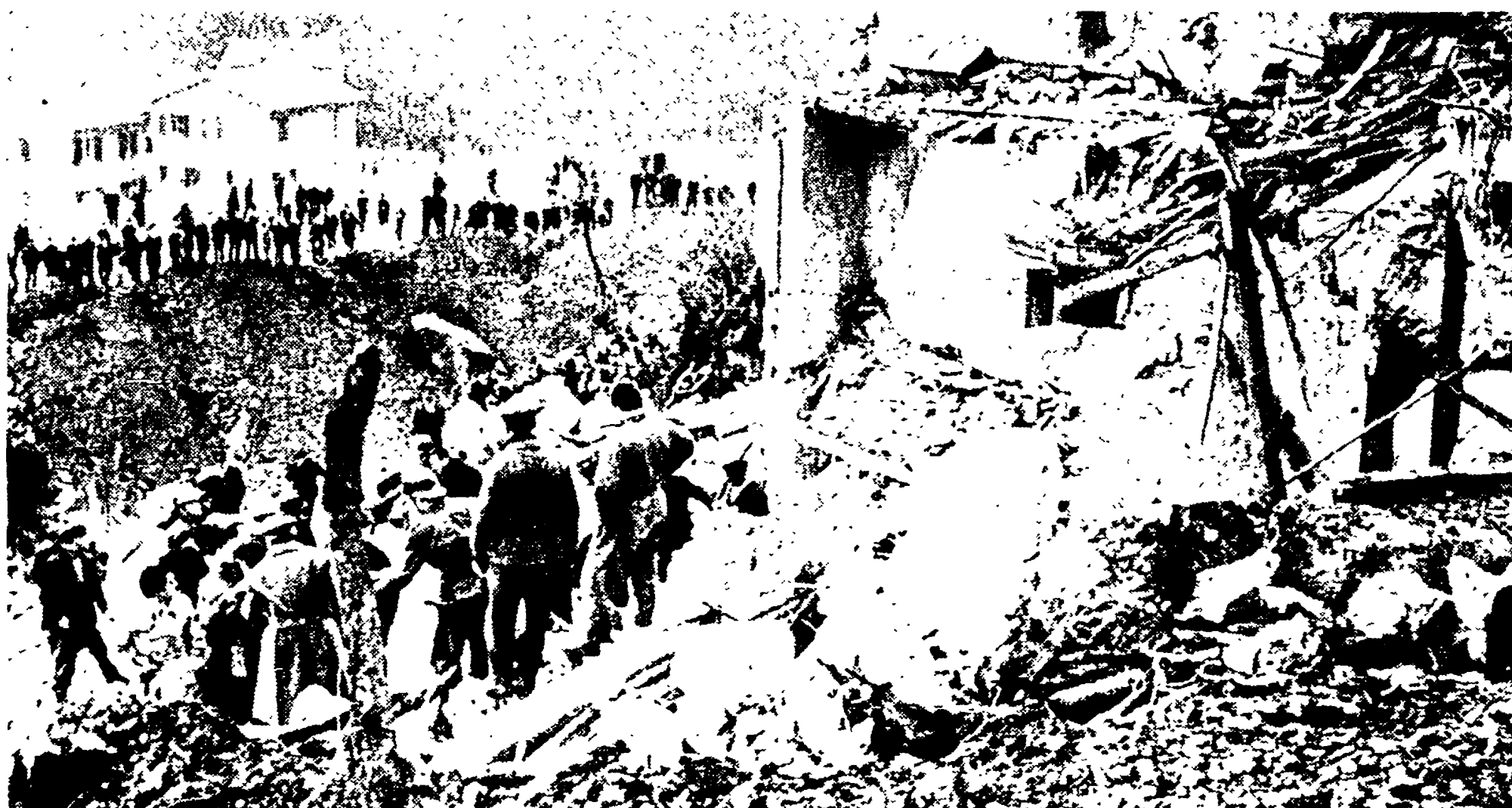
LECCO — Una visione della spaventosa tragedia che ha travolto tre famiglie di immigrati calabresi. Dopo la frana la casa si è trasformata in un cumulo di macerie.
