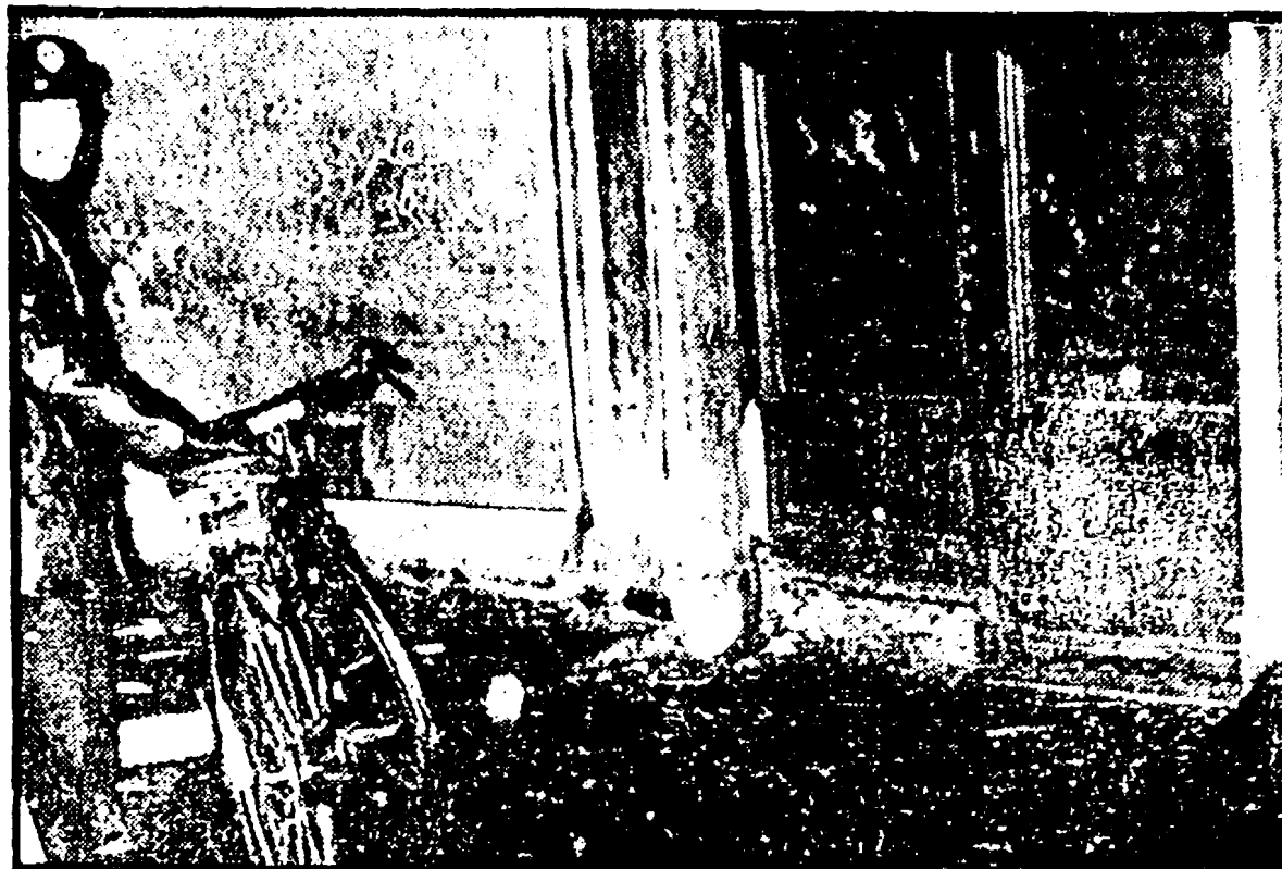
Il portone di Palazzo Madama danneggiato dallo scoppio della bomba
