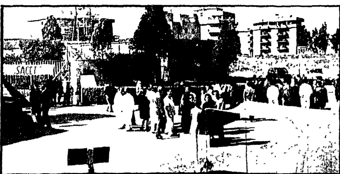
Gli operai della SACET picchellano la fabbrica dopo la provocatoria serrata
