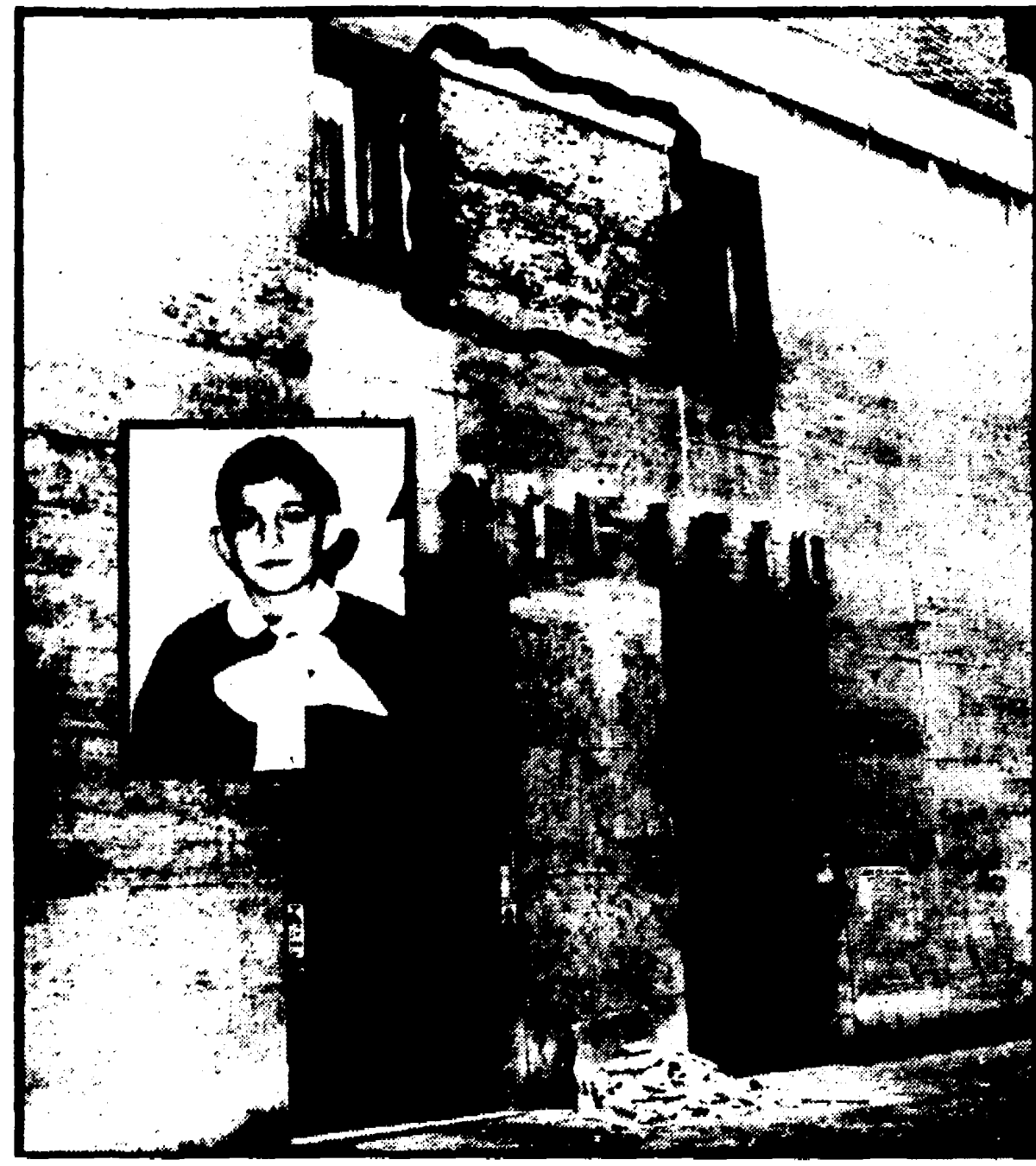
Il luogo in cui si è verificato il crollo del lastrone di travertino che ha ferito gravemente lo scolare: è visibile il punto da cui il marmo si è staccato. Nel riquadro: Stefano Gagliarone
