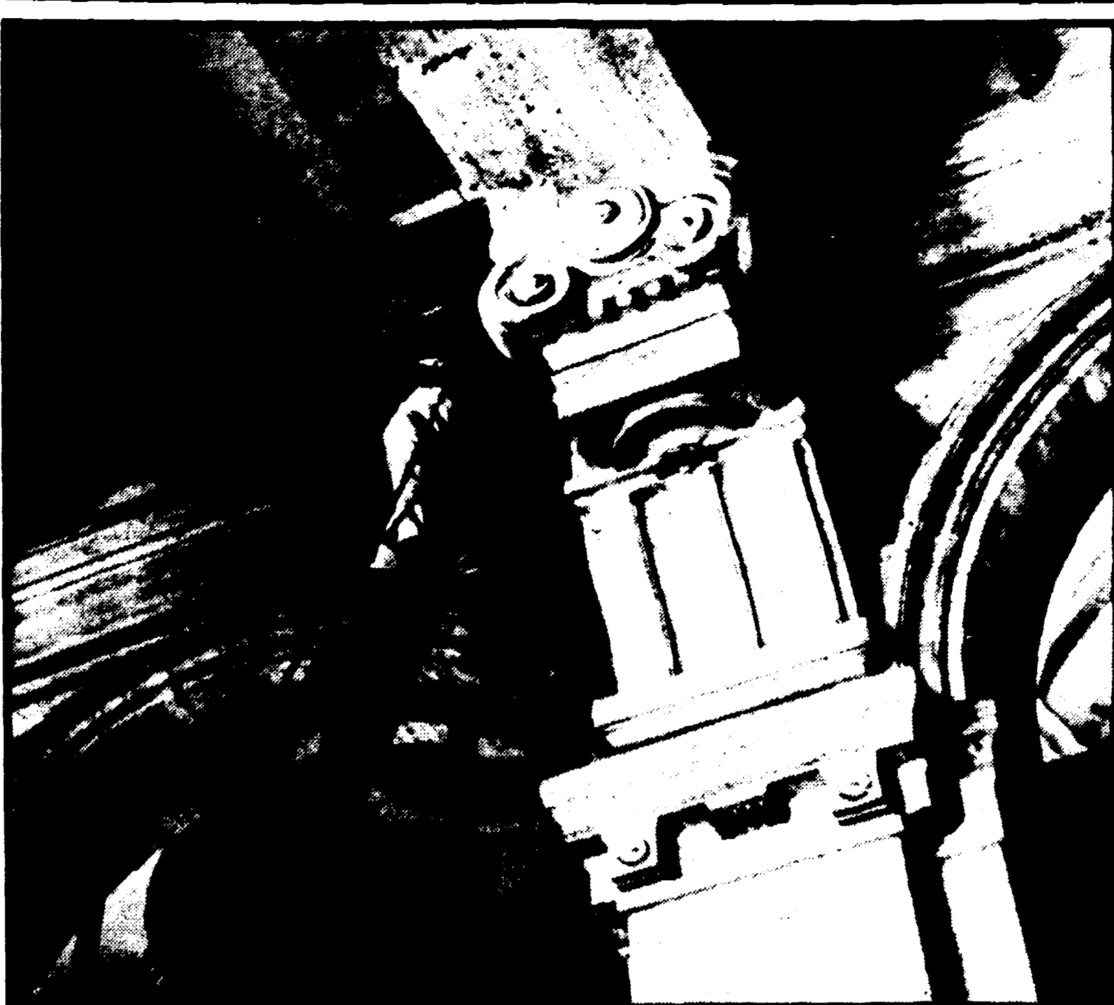
Ieri è stato compiuto un nuovo sopralluogo al Palazzaccio. Nella foto si nota un operaio che sta controllando il punto da dove si è staccato, l'altro giorno, il pesante masso di travertino.
