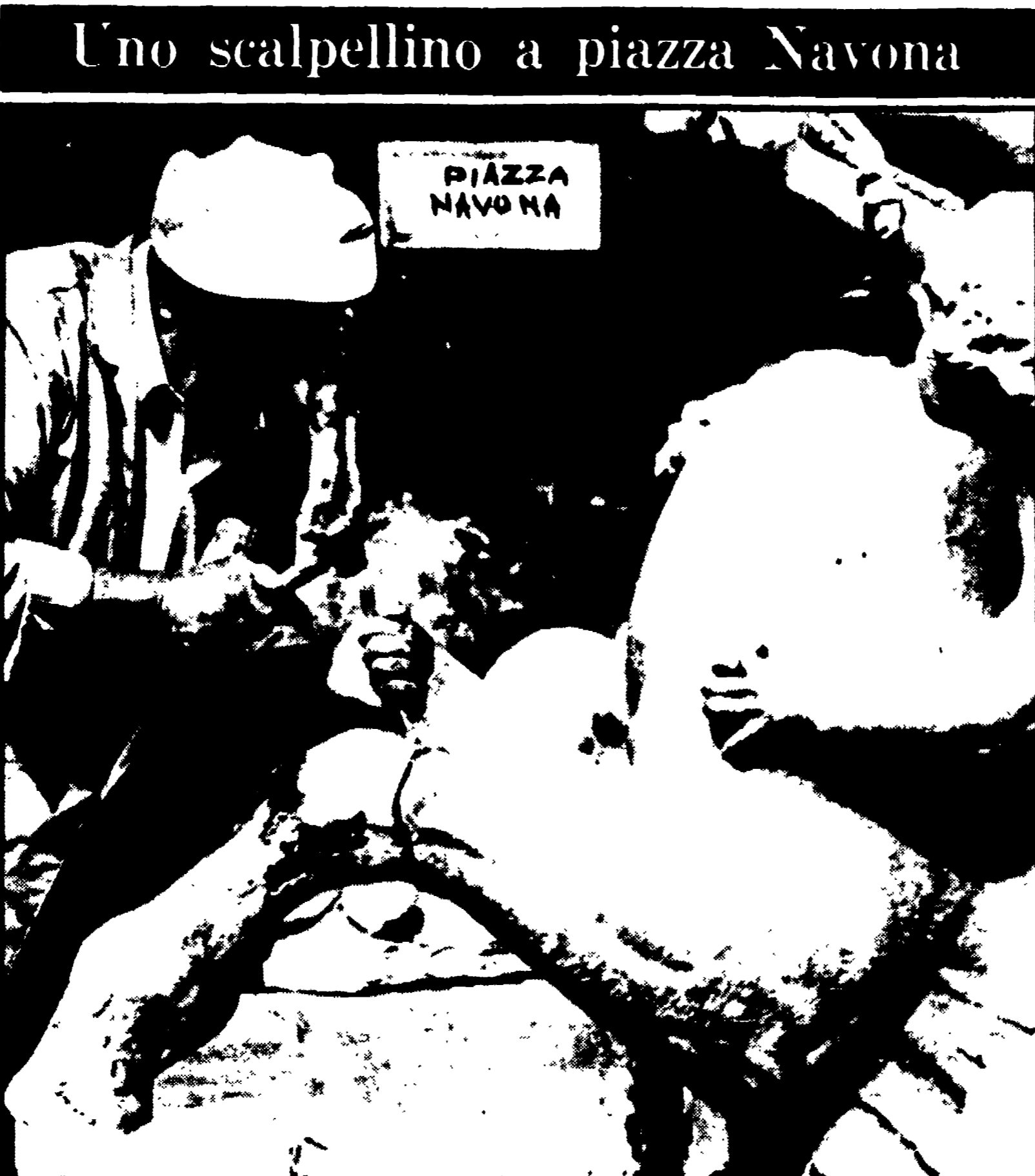
Uno scalpellino nell'assolata piazza Navona. Tra turisti incuriositi, Gildo Fina, uno degli ultimi esperti nell'arte del marmo e del travertino, riattaccava ieri mattina una zampa al cavallo marino di una delle tre fontane che ornano la suggestiva piazza.
